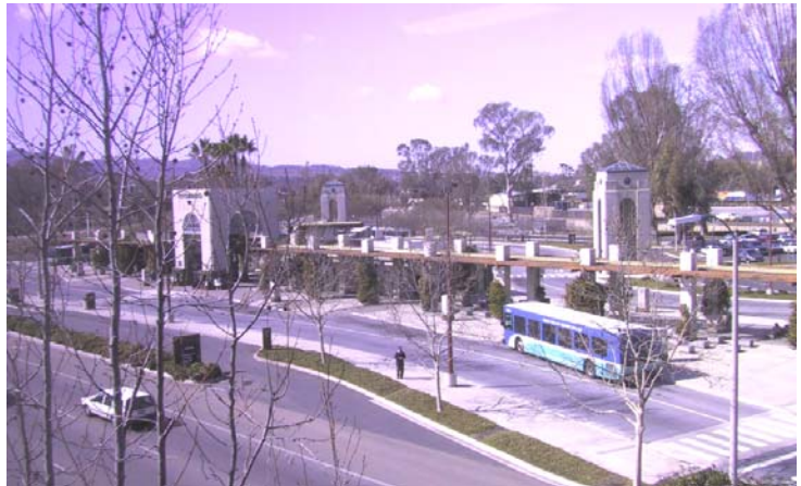
The Escondido Transit Center
